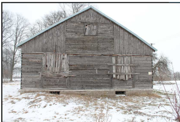
Fot. 17. Borkowo-Falenta, piwnice z dogodnymi wlotami – bardzo dobre potencjalne zimowisko w opuszczonym gospodarstwie – brak wejścia uniemożliwił kontrolę.
